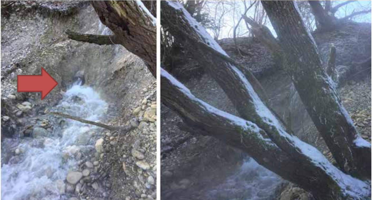
Abbildung: Erodierter Auslauf und Böschung des Lechs
